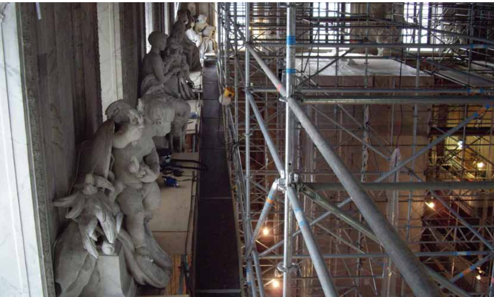
Taket i Rikssalen på Kungl. Slottet har renoverats och målats om.
