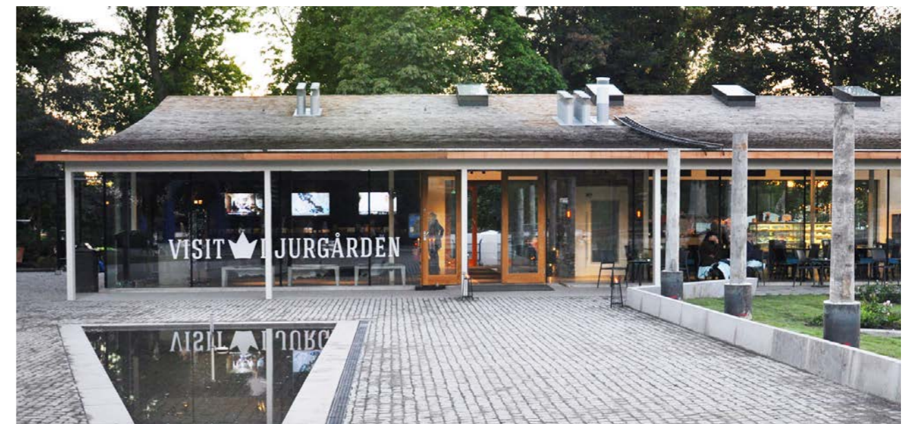
Kungen invigde Visit Djurgården, det nya besökscentret vid Djurgårdsbron.
